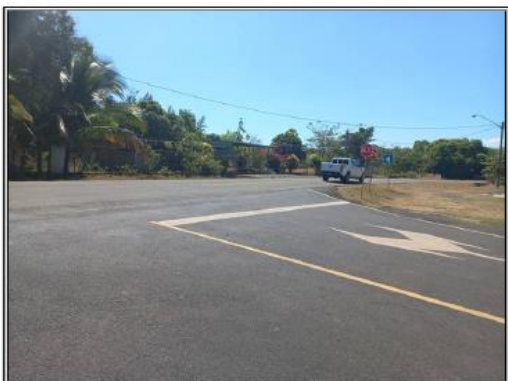
Vista del Sector
