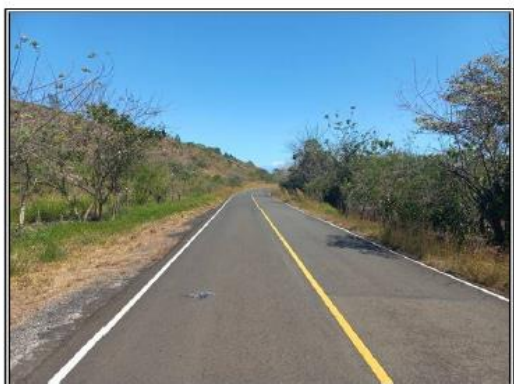
Calle de Acceso
