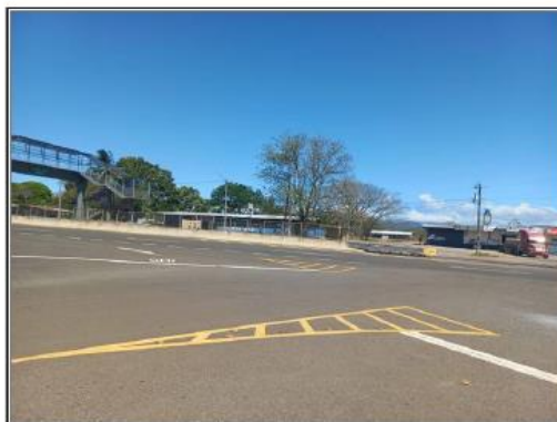
Vista del Sector
